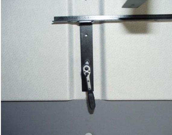
Entfernen Sie zunächst die beiden Kleiderhaken und die oberen Schrauben der Bettenhalterung (falls vorhanden).
