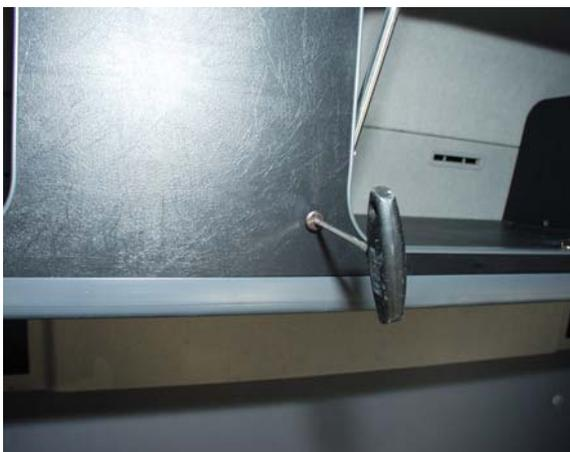
Verschrauben Sie die Frontblende mit den Trennwänden mittels 8x Flachkopfschrauben M6x60.
