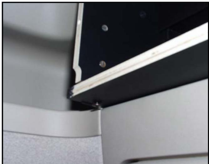
**Schieben Sie nun die Frontblende mit dem Eckprofil auf die Bodenplatte und verschrauben Sie die Blende mittels Flachkopfschrauben M6x60 mit den Trennwänden.**
